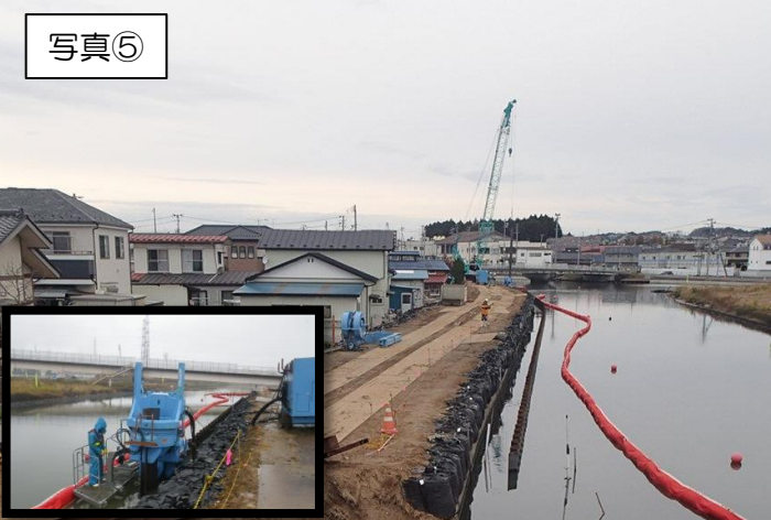
旧砂押川C工区区表基礎矢板打込み完了。引き続き裏法基礎工に移行しています。旧砂押川A工区は、既設の張ブロックを撤去して裏法基礎工矢板打込みを開始しています。
