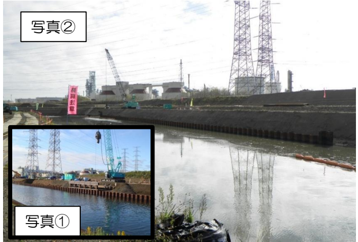
中洲・JXエリアにて崩れた構造物撤去と、鋼矢板打設を継続しています。貞山運河に新仙流橋建設のための仮橋設置工事を開始しています。
