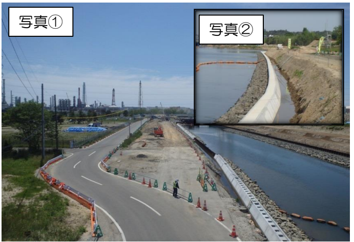
写真① 貞山運河にて捨石投入、川表基礎構築を継続しています。新仙流橋建設においては橋台・橋脚の施工を継続し、七ヶ浜町水路取替工事も継続しています。
