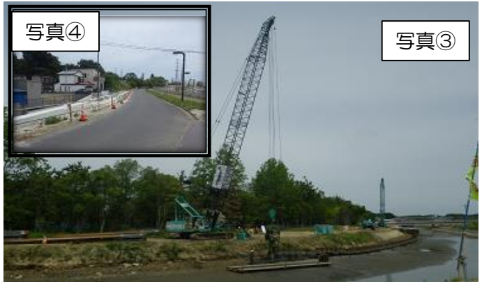
写真③ 旧砂押川左岸(貞園橋上流)にて鋼矢板打設を継続中です。多賀城緑地公園道路の付替工事を切替えに向けて施工中です。 ※インターネット利用で工事の状況が見られます。 ページURL http://www.gembaroid.net で ID:hc0802、パスワード:998633を入力ください。(AM 9:00 ~PM 5:00)
