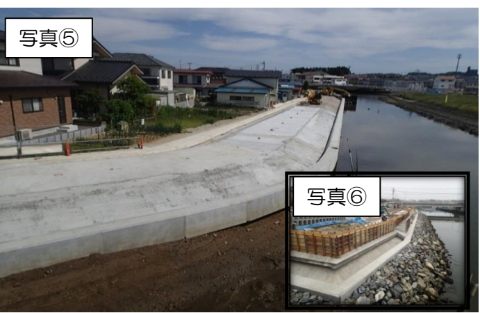
写真⑤ 旧砂押川C工区(橋本橋～貞園橋間左岸)は、貞園橋方向より施工を進め現在被覆工を行っています。B工区は天端被覆工の特殊堤の施工を行っています。A工区は、天端被覆工と同時に起点側の捨石工を行っています。
