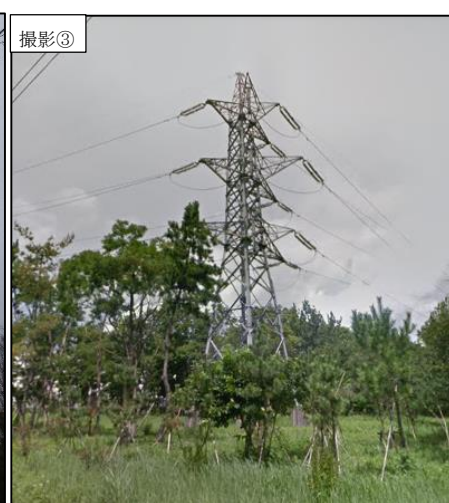
張替終了鉄塔
