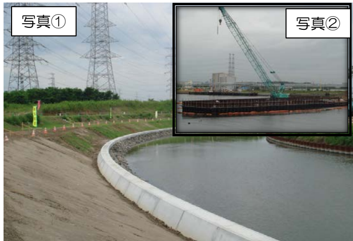
貞山運河では川表・川裏基礎構築を継続し、旧砂押川では法面整形・盛土を開始しています。新仙流橋建設においては盆明けに上部桁架設を実施します。砂押川河口では矢板打設が完了しています。
