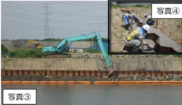
写真③は砂押川右岸側での捨石投入状況です。写真④は旧砂押川左岸側での川裏基礎均しコンクリート打設作業状況です。※インターネット利用で工事の状況が見れます。ページURL http://www.gembaroid.net で ID:hc0802,パスワード:998633を入力ください。(AM 9:00 ~PM 5:00)
