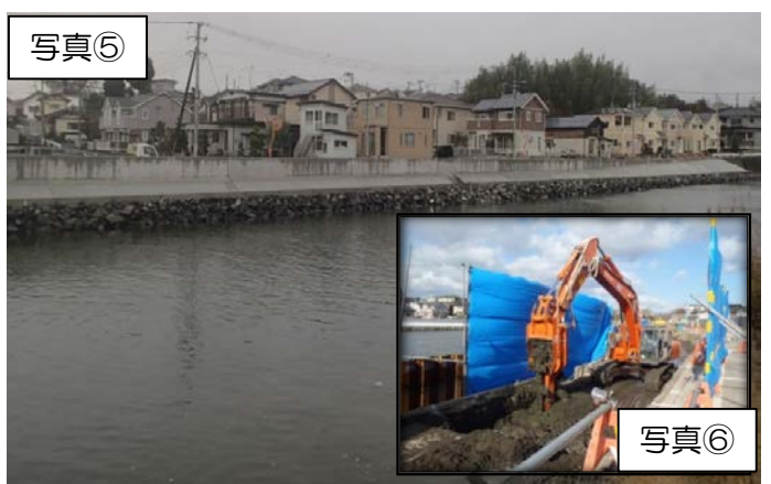
旧砂押川A工区はコンクリート被覆工完工し、堤脚水路工を行っています。C工区(橋本橋～貞園橋間左岸)は、橋本橋付近の表裏法被覆工の施工を行っています。E工区船溜まり場については、地盤の改良工事及び鋼管杭工事を行っています。F工区は、基礎コンクリートを完工し捨石工を行っていく予定です。連日片側交互通行のご協力ありがとうございます。
