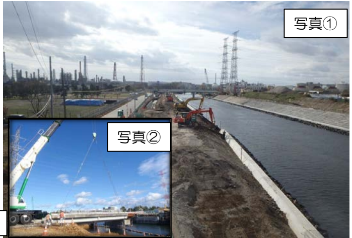
貞山運河では盛土と法面被覆工を継続し、旧橋撤去も進めています。旧砂押川では法面被覆工を継続、砂押川では捨石工と特殊堤(壁堤防)構築を継続しています。
