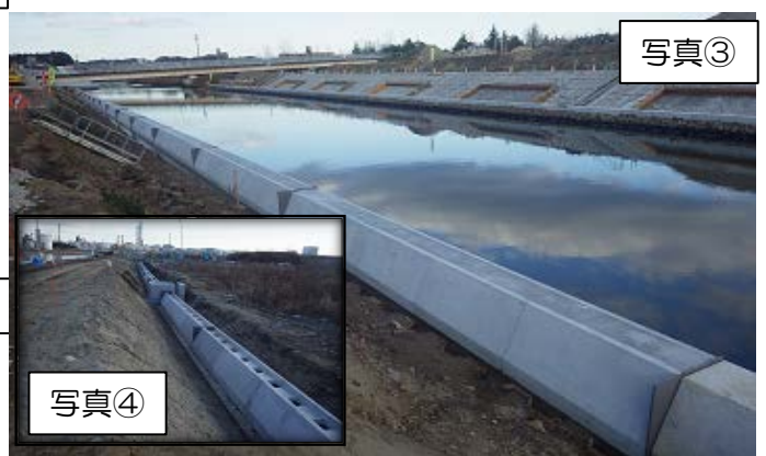
写真③は旧砂押川左岸側、川表の笠コンクリートの施工を進めております。写真④は同じく砂押川右岸での川裏基礎コンクリートの施工を進めております。※インターネット利用で工事の状況が見れます。ページURL http://www.gembaroid.net で ID:hc0802,パスワード:998633を入力ください。(AM 9:00 ~PM 5:00)
