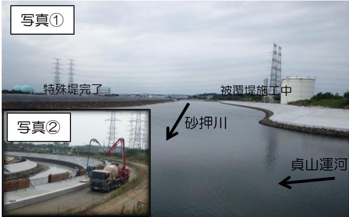
貞山運河と旧砂押川では被覆工を継続で進めています。砂押川では被覆工を継続し、特殊堤(壁堤防)構築が完了しました。多賀城市道では、片側交互通行にて市道嵩上げ工事を開始しています。
