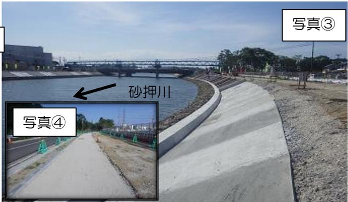
写真③は砂押川左岸側、川表法面被覆の施工を行っております。写真④は公園道路(付替道路)の歩道路盤の施工状況です。※インターネット利用で工事の状況が見れます。ページURL <http://www.gembaroid.net> で ID:hc0802、パスワード:998633 を入力ください。(AM 9:00 ~PM 5:00)
