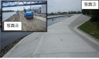
写真③は旧砂押川左岸側(貞園橋上流側)の被覆コンクリートの施工 状況です。徐々に仕上がっております。 写真④は砂押川右岸側で の河川堤防盛土工で、転圧作業を行っております。
