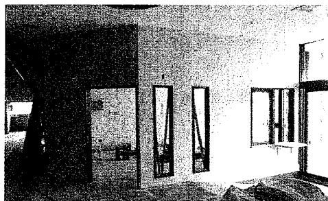
事務室の壁が張られ、次は内部の工事です。
